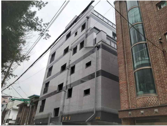
건물 외부 전경
