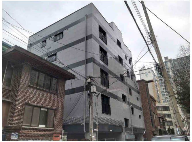
건물 외부 전경
