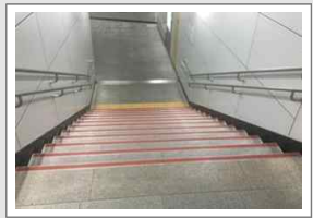
② 계단 노슬림 설치
