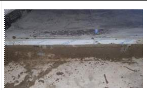
사진5-1. 문틀 하부 몰탈 채움 보완
