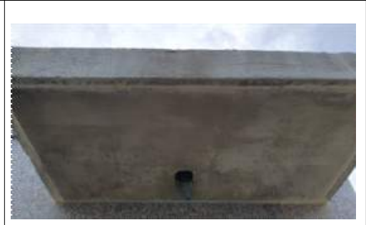
사진1-1. 옥탑 출입문상부 케노피 물끊기 홈 설치
