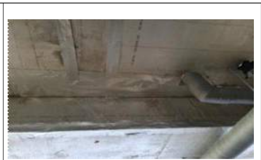
사진3-1. 단열재 하부 페이스트 제거 후 방화테이프 부착
