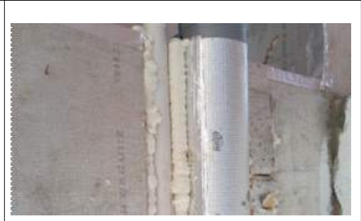
사진2-1. 피로티 천정 배관 수정부위 단열재 보완 설치
