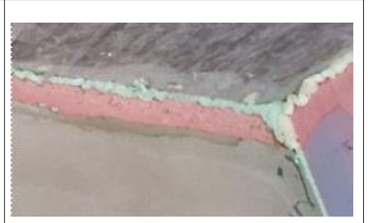
사진6-1. 단열재 위 페이스트 제거 완료
