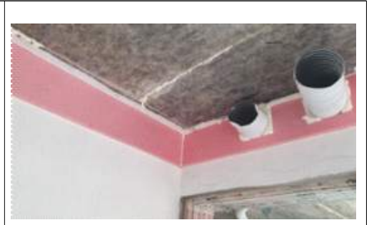
사진4-1. 결로 방지재 아이소 핑크 10T 설치
