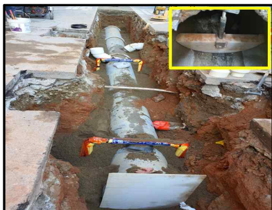
〈물돌리기 시공 양호〉
