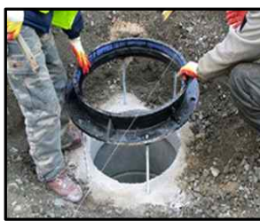
② 맨홀뚜껑 받침 설치
