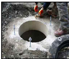
① 앵카볼트 설치
