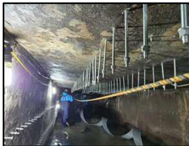
〈공사장 내부관리 양호〉
