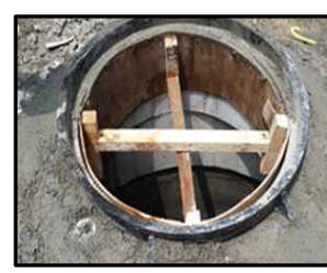
④ 콘크리트 타설
