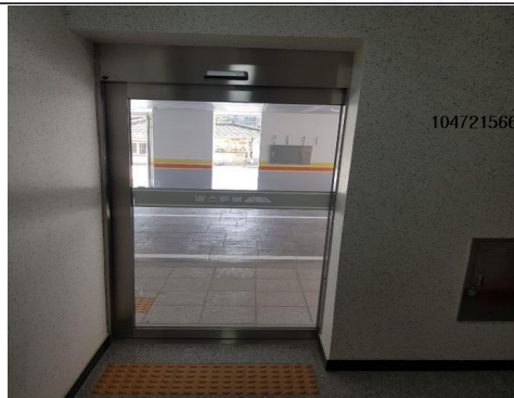
동출입구 현관 전경(내부)
