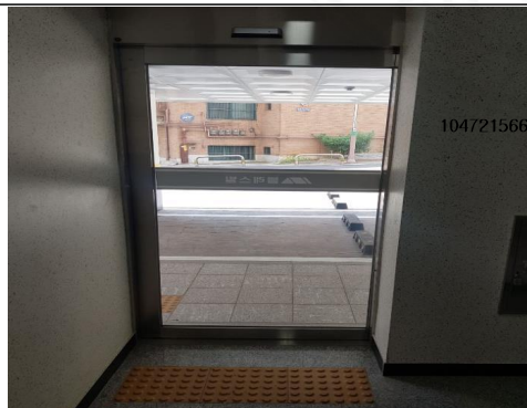
동출입구 현관 전경(내부)
