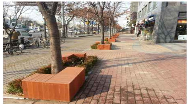
[공사후] 강동 상떼빌 공개공지 앞(가로정원)
