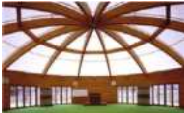
体育館などのドーム屋根
