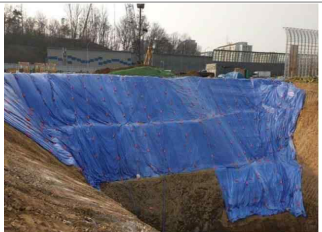
- 토공작업 완료 후 천막보양 완료
