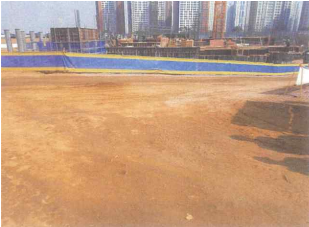
- 단지 외부 우수 배수로 설치
