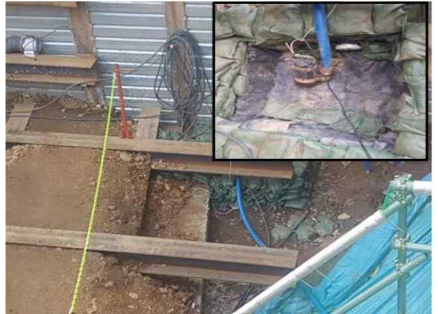
- 가배수로 정비 후 집수정 추가 설치 완료
