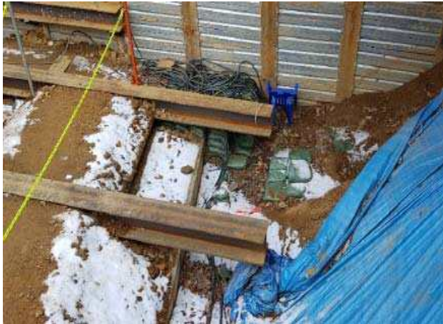
- 가배수로 정비 및 집수정 추가설치
