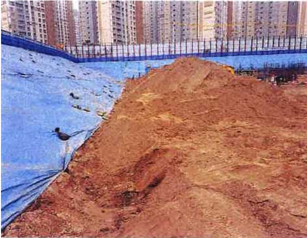
- 사면 배수로 정비
