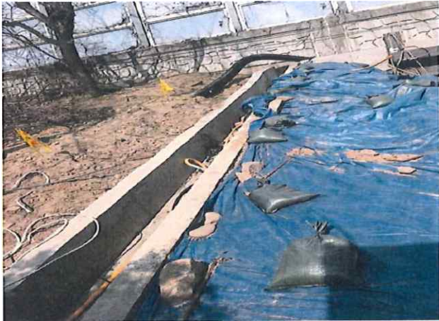
- 배수로 준설 및 정비
