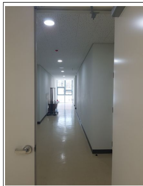
관찰실 방화문 개방 후 내부로 진입
