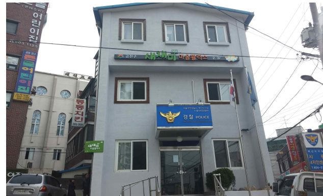
(금천구 새재미 마을활력소) 치안센터 유휴 공간(2·3층)을 활용하여 공유부엌, 민회방 등을 조성하고 주민이 전담 운영
