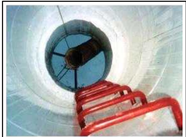
콘크리트 라이닝 설치 전경
