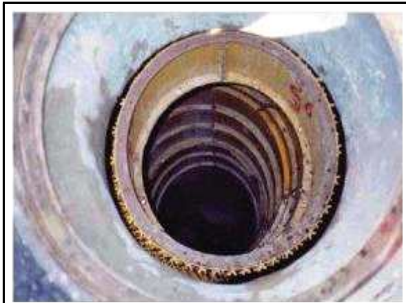
맨홀 내부 거푸집 설치
