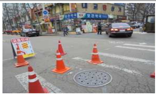
맨홀 상부 전경
