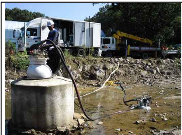
공기를 이용한 라이닝 경화 및 양생
