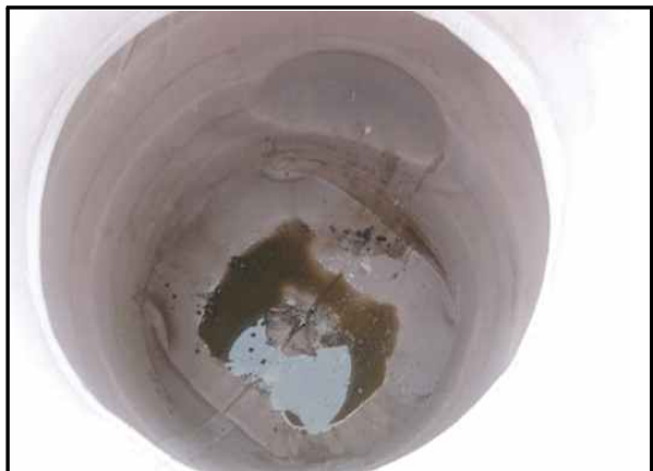
라이닝 경화 후 내부 전경
