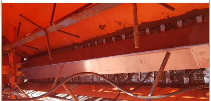
15톤살포기(3호) / 인버터 교환 후
