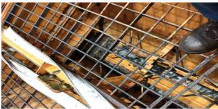
다목적살포기(1163) / 호퍼내부도장 전
