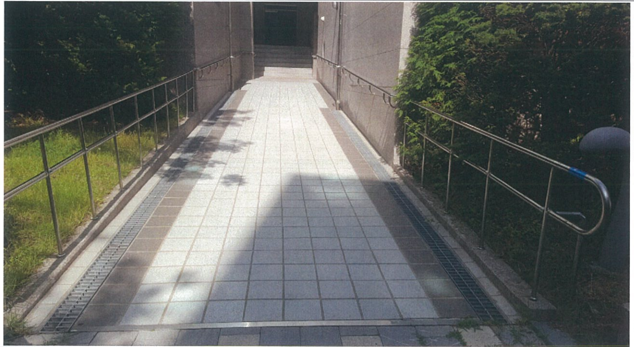
1107동 T102호 진입로 공사전
