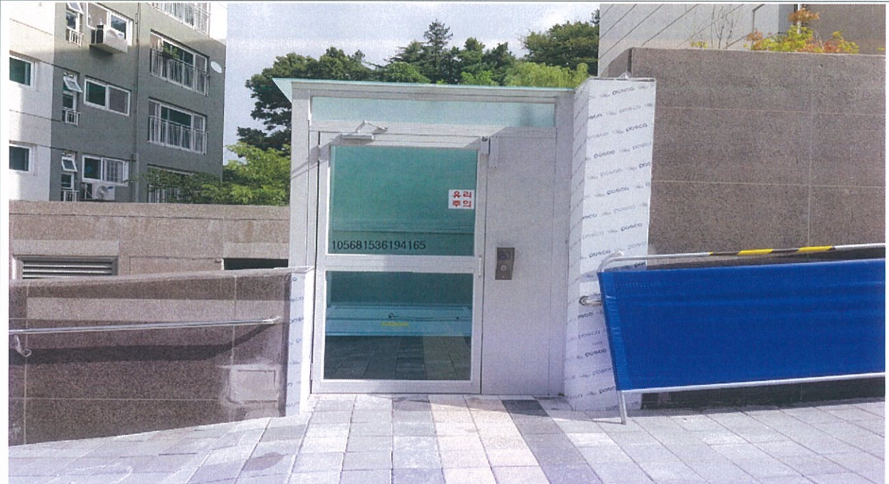
1109동 수직형 휠체어 리프트 공사후
