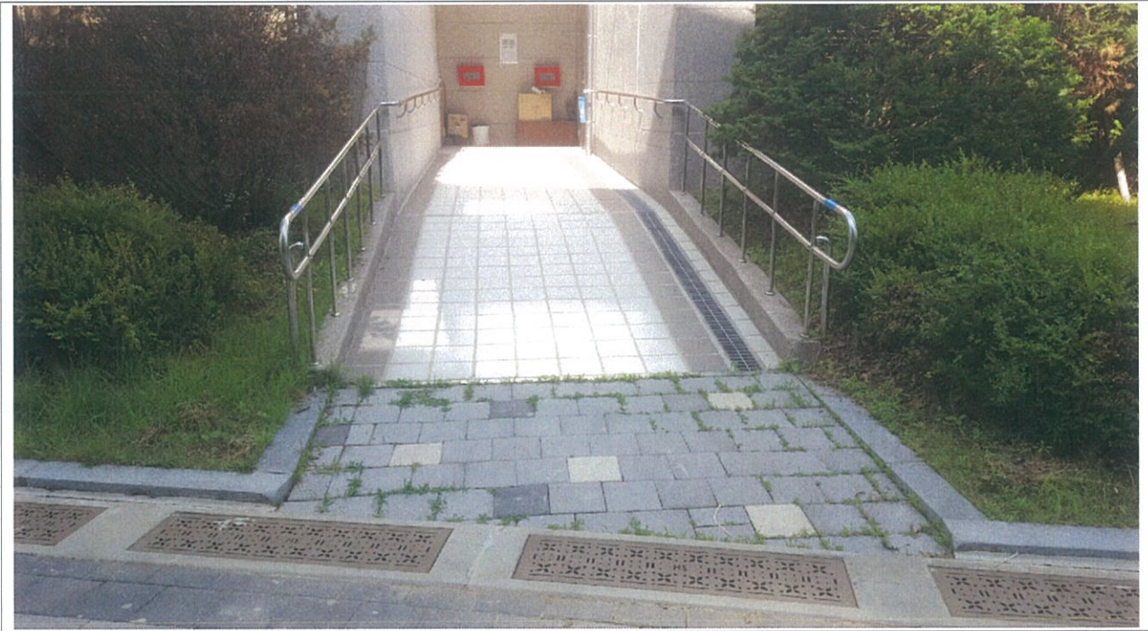
1107동 T101호 진입로 공사전
