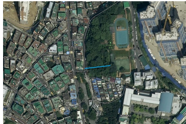
만리배수지 작업구간 위성사진
