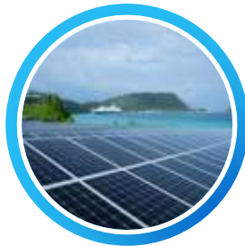
태양광발전 물재생센터 내 전력 공급 남은 전력은 판매
