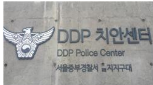
외부유도사인 탈락 및 훼손
