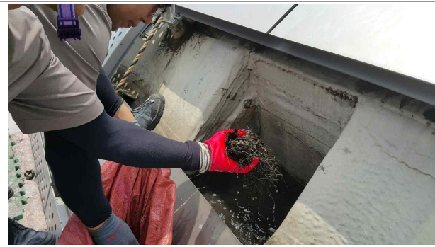
사이포닉 드레인 점검 및 보수
