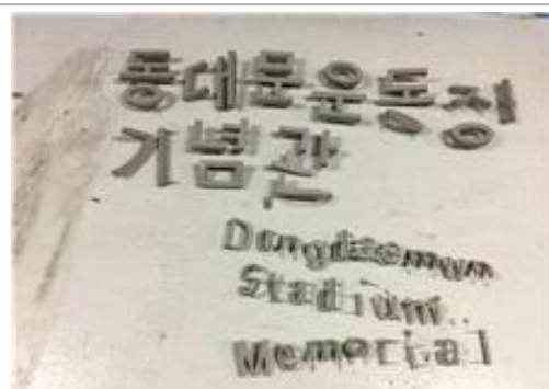
외벽 보수공사로 인한 게이트사인 탈락
