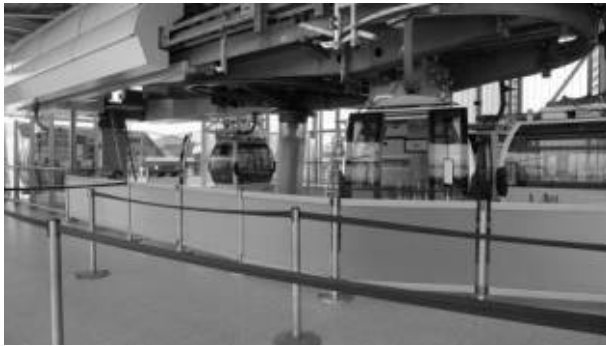
에미레이트 로얄독역의 승강장, 하부에 동력실 위치
