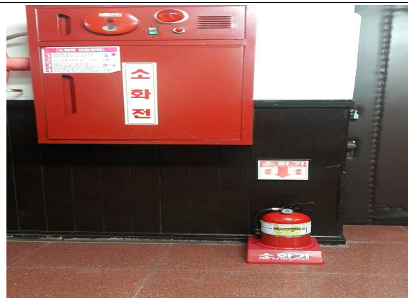
소화전 소화기 상태 양호
