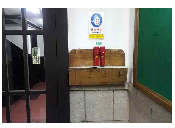
비상조명등 상태 양호
