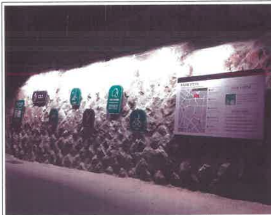
(자료3) 옹벽 환경개선 조명 설치로 안전한 보행환경 조성
