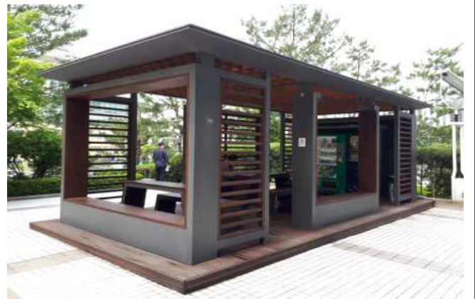
설치 대상 파고라 측면
