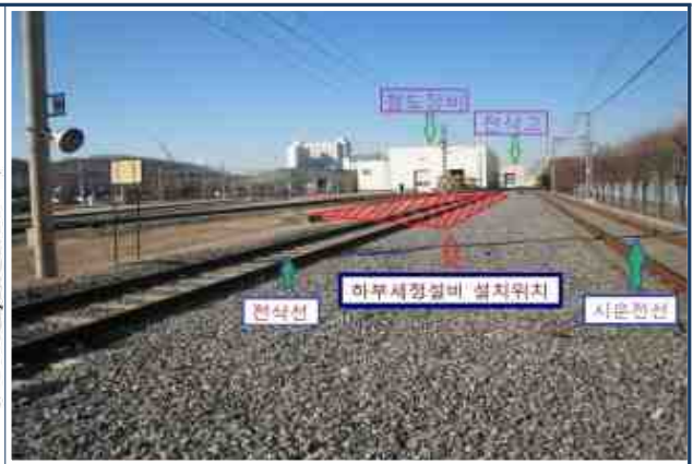
전삭고 앞 하부세정설비 설치위치
