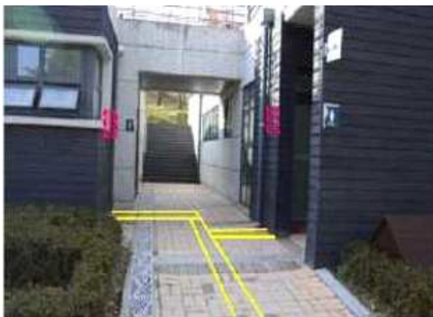
점자블럭 및 촉지안내판 설치
