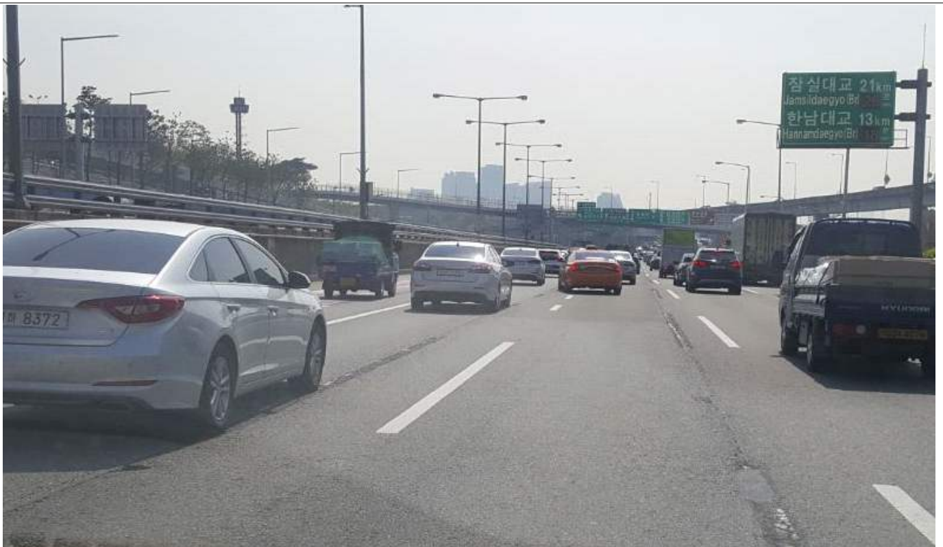
아스콘 포장도로 현황(강변북로 구리방향, '18.04.17)
