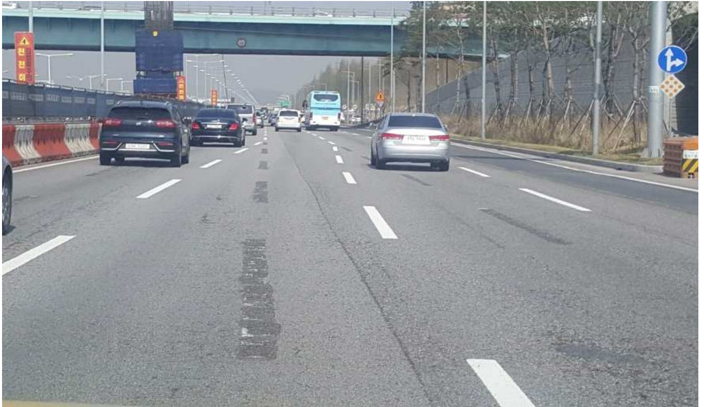
아스콘 포장도로 현황(강변북로 난지방향, '18.04.17)
