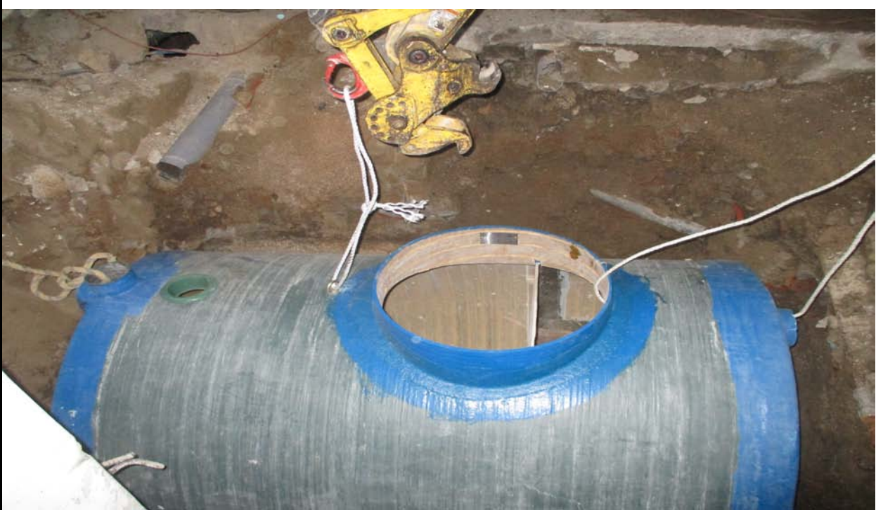
사 진 설 명 | FRP 10인용 정화조 설치
