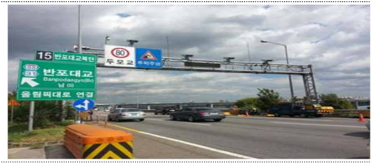
< 운행제한 시스템 CCTV 설치 전경 >
