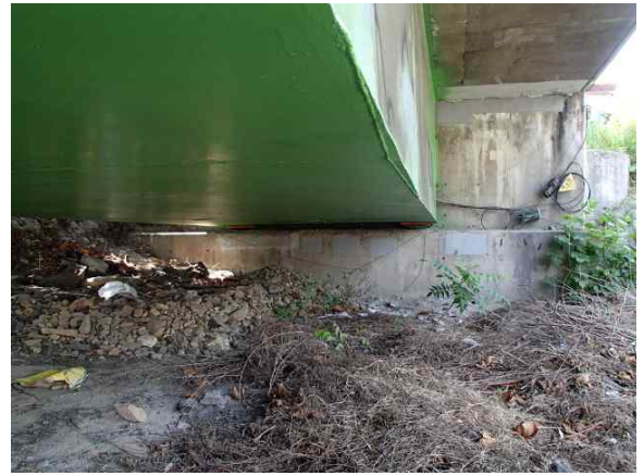
교대 A2 전경 (하행선)
