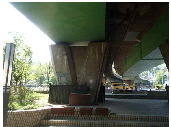
교각 P8 전경 (하행선)
