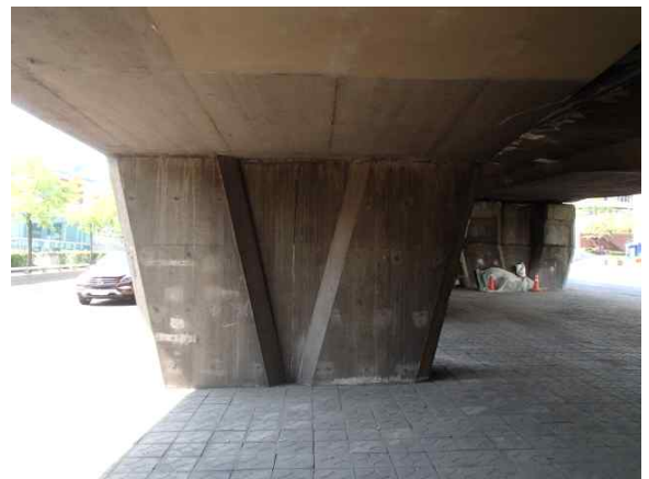
교각 P3 전경 (하행선)
