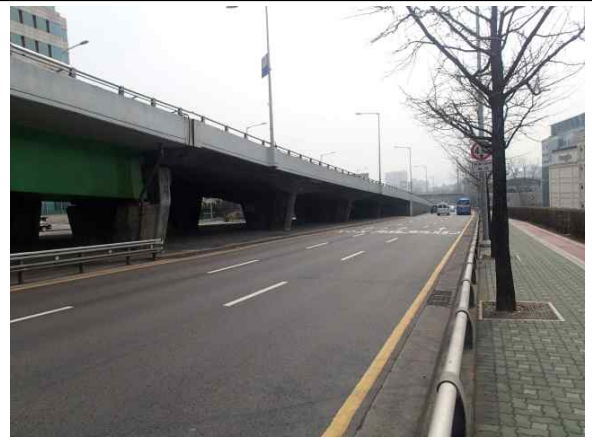
라멘구간 전경 (하행선)
