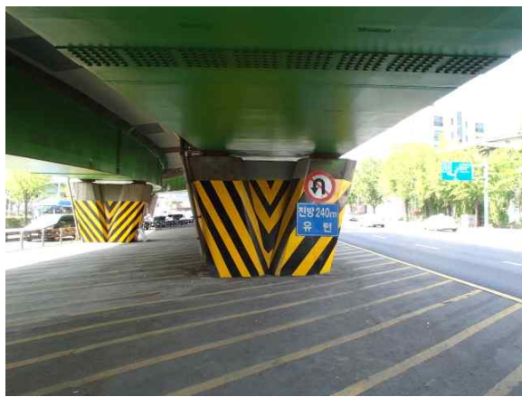
교각 P5 전경 (상행선)
