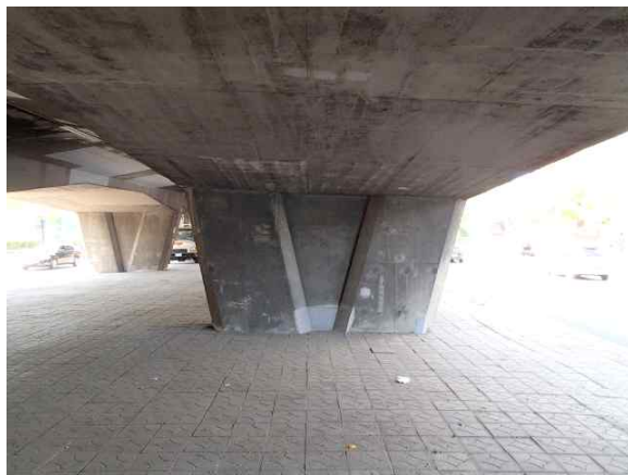
교각 P2 전경 (상행선)
