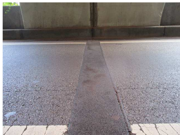
S16경간 신축이음부 탄성봉함재 설치전경
