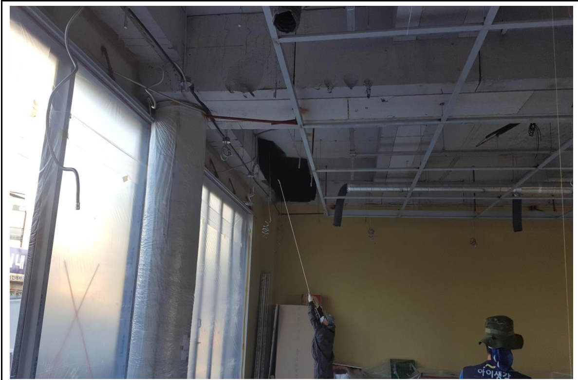
사진설명: 천정 메쉬철망 골조 및 천정 내부 도색- 공사중
