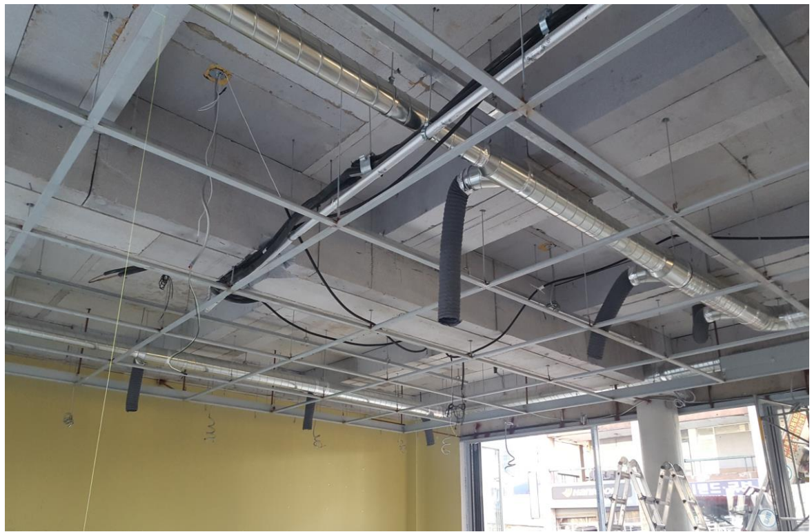
사진설명: 천정 메쉬철망 골조 작업- 공사중
