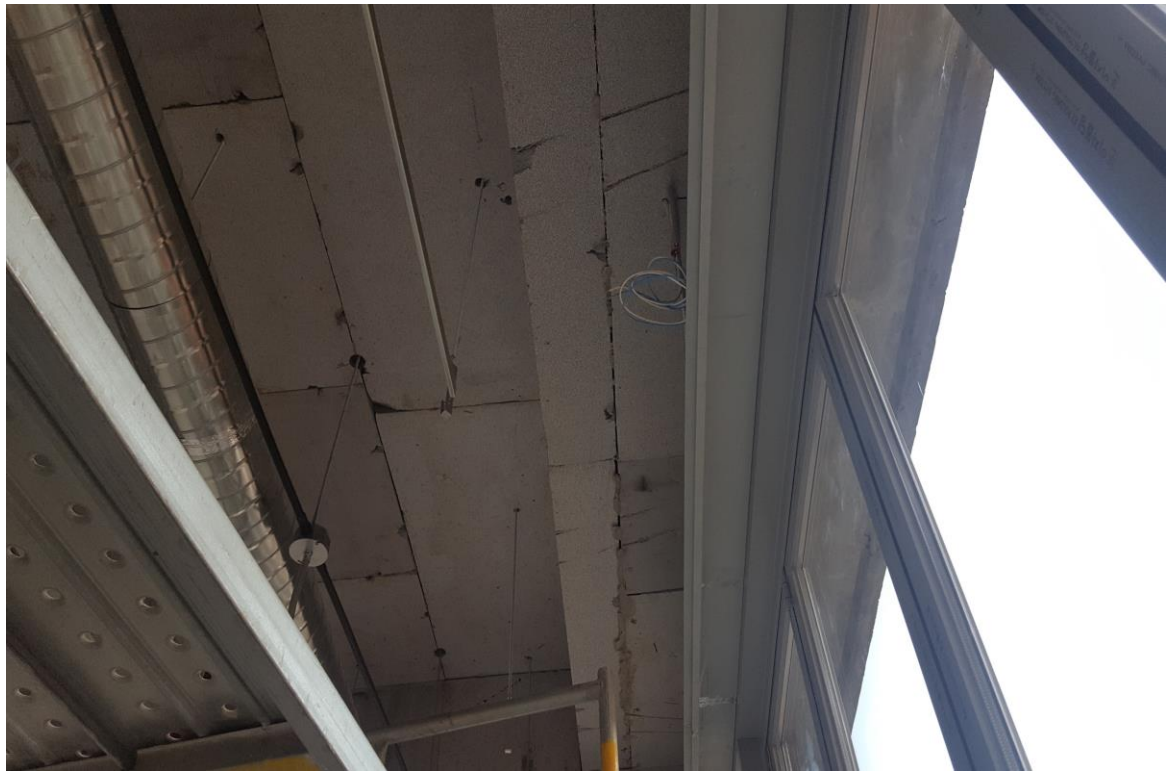
사진설명: 커튼박스 설치 작업- 공사중
