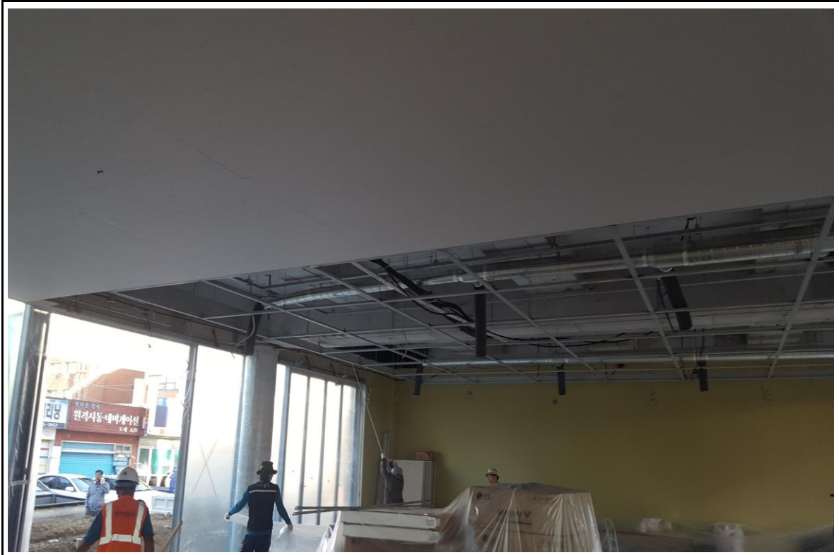
사진설명: 경량철골 천정 및 석고보드 취부- 공사중
