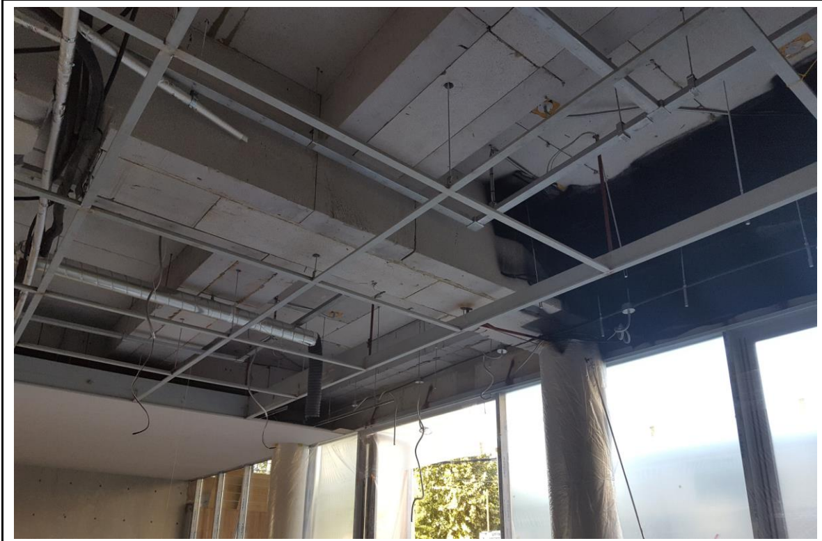
사진설명: 천정 메쉬철망 골조 작업- 공사중
