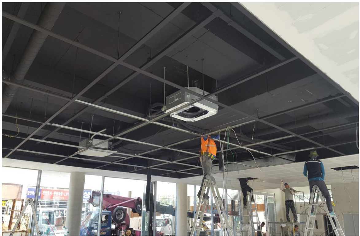
사진설명: 도장 천정 내부 작업- 공사중
