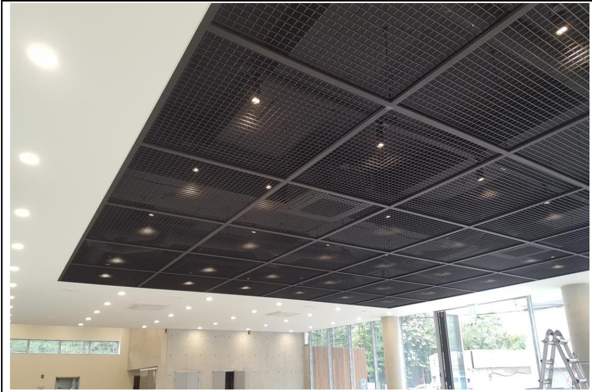
사진설명: 메쉬철망 설치 및 도장 작업 - 공사 완료
