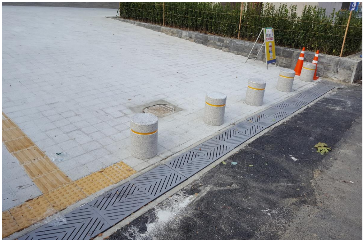
사진설명: 외부 대리석 블라드 설치 - 공사 완료
