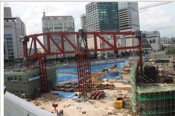
캔틸레버보(메가트러스 설치 당시)-1
