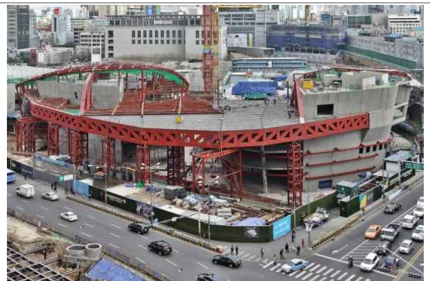
캔틸레버보(메가트러스 설치 당시)-2
