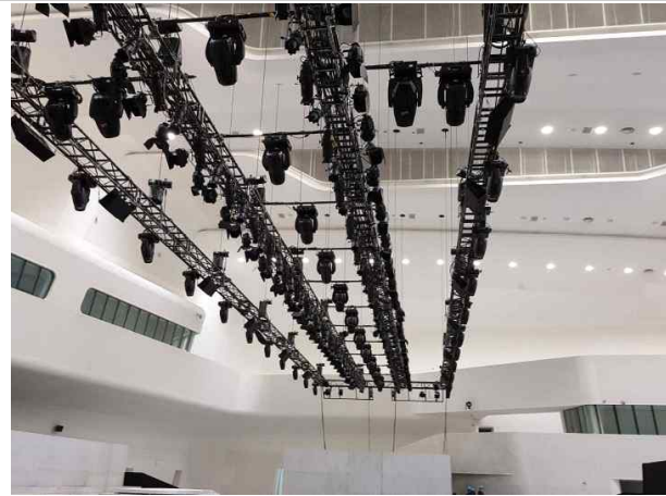
알림1관 천정 조명 트러스 설치 사진
