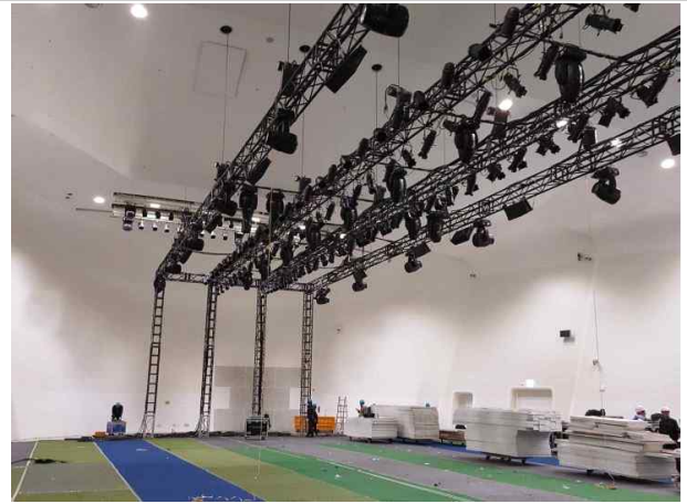
알림2관 천정 조명 트러스 설치 사진
