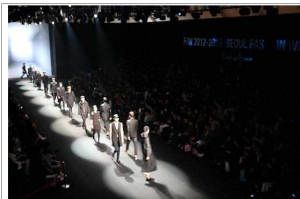
패션위크 행사 천정 조명트러스 설치사례-1
