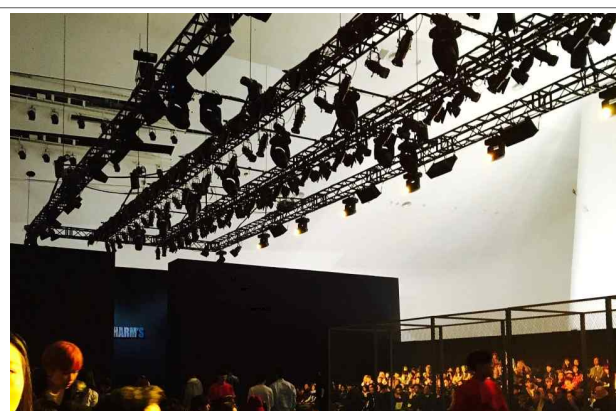
패션위크 행사 천정 조명트러스 설치사례-2
