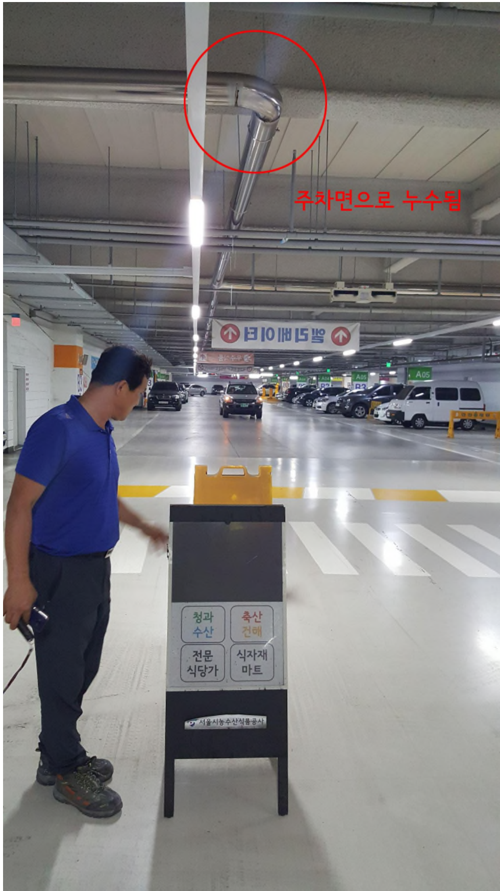
( 판매동 지하3층 주차장 )
