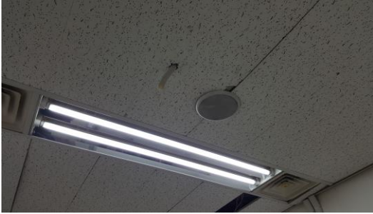
감지기 설치 전
