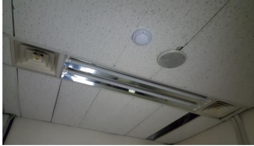
감지기 설치 완료
