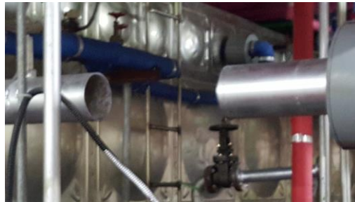
소방 펌프 성능시험배관 교체 중
