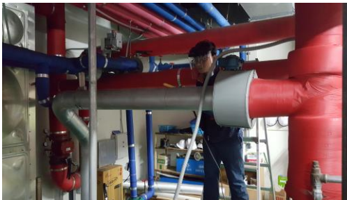
소방 펌프 성능시험배관 교체 중
