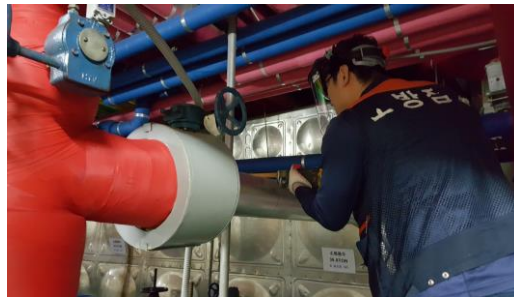
소방 펌프 성능시험배관 교체 중
