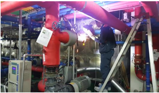
소방 펌프 성능시험배관 교체 중
