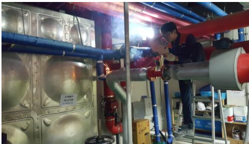
소방 펌프 성능시험배관 교체 중
