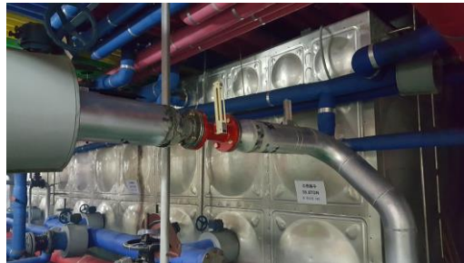
소방 펌프 성능시험배관 교체 중
