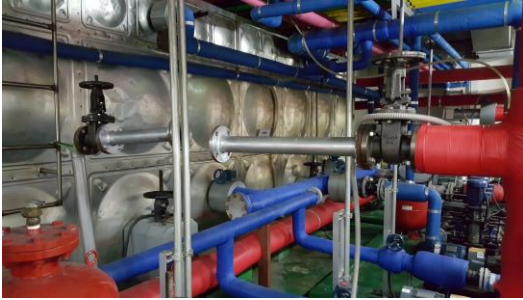
소방 펌프 성능시험배관 교체 중
