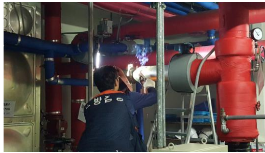
소방 펌프 성능시험배관 교체 중
