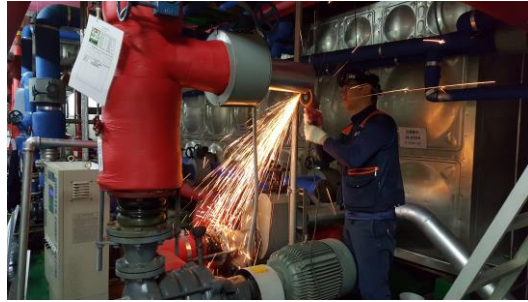
소방 펌프 성능시험배관 교체 중
