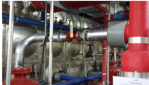
소방 펌프 성능시험배관 교체 완료
