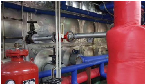
소방 펌프 성능시험배관 교체 완료
