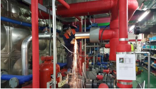
소방 펌프 성능시험배관 교체 중
