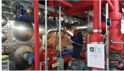
소방 펌프 성능시험배관 교체 중
