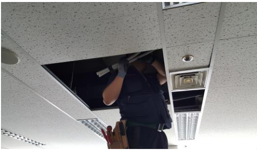
에어컨 라인 전기 보수 중
