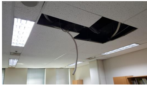
에어컨 라인 전기 보수 중
