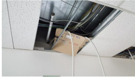
에어컨 라인 전기 보수 중
