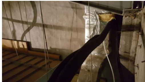
에어컨 라인 전기 보수 중
