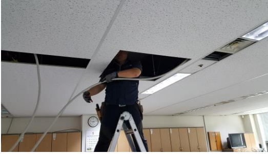
에어컨 라인 전기 보수 중
