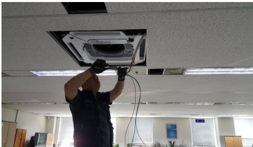
에어컨 라인 전기 보수 중
