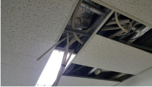
에어컨 라인 전기 보수 중
