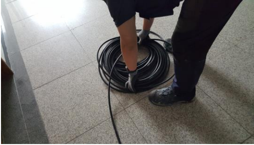
에어컨 라인 전기 보수 중
