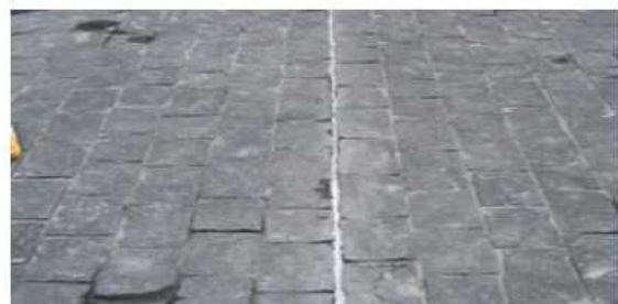
(d) 신축줄눈 시공 사례
