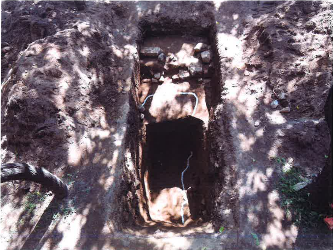
【사진 11】 5트렌치 전경
