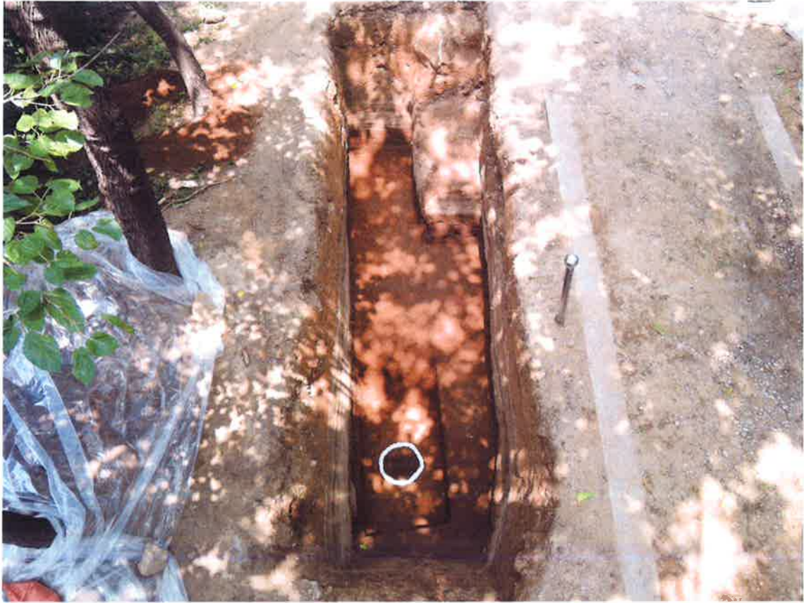
【사진 15】 9트렌치 전경
