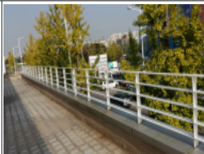
2층 발코니 난간대 도장보수
