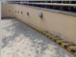
주차장 바닥 및 벽체
