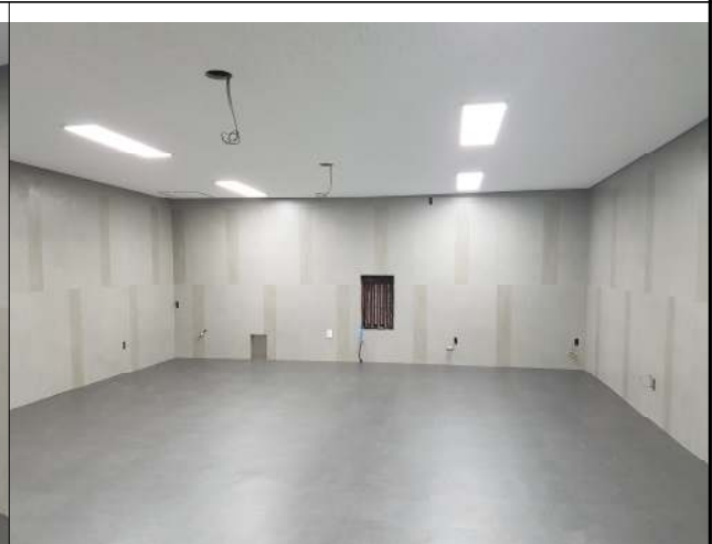
[화곡서비스지원사업소 조성공사 현장 전경]
