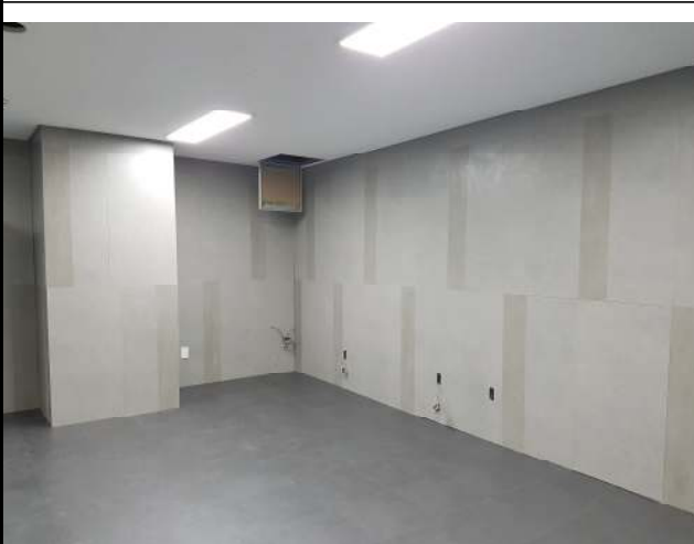
[화곡서비스지원사업소 조성공사 현장 전경]
