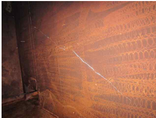
<2정수지 내부 전경>
