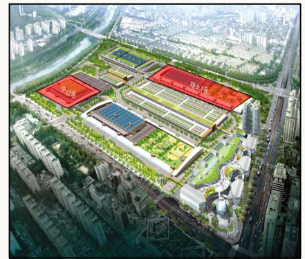
<도매권역 2공구 사업 부지>
