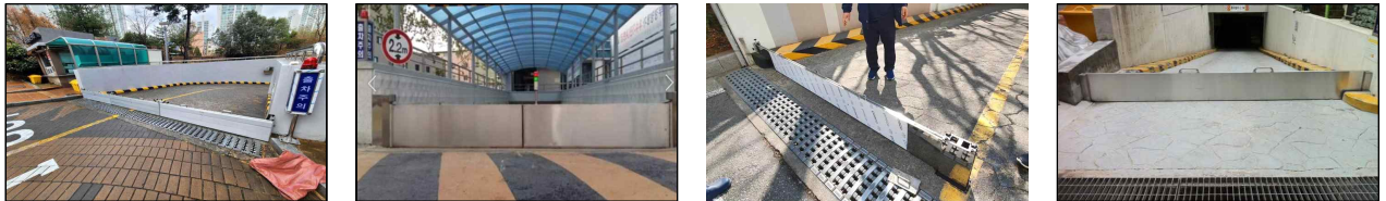
< 지하주차장 물막이판 설치 사진 >
