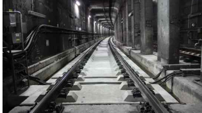
혜화~동대문 콘크리트 도상(개량후)
