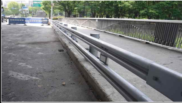
난간 및 연석 전경(차도부)
