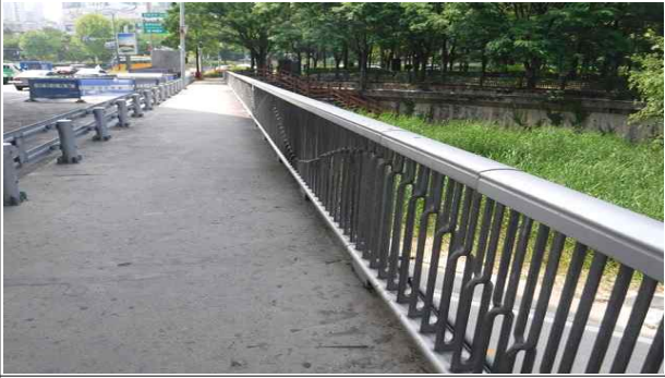
난간 및 연석 전경(보도부)
