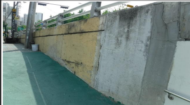
접속옹벽 전경(시점 좌측)
