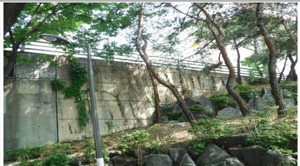
접속옹벽 전경(시점 우측)
