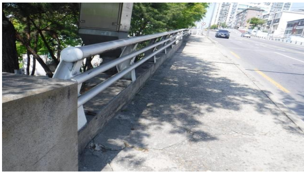
난간 및 연석 전경
