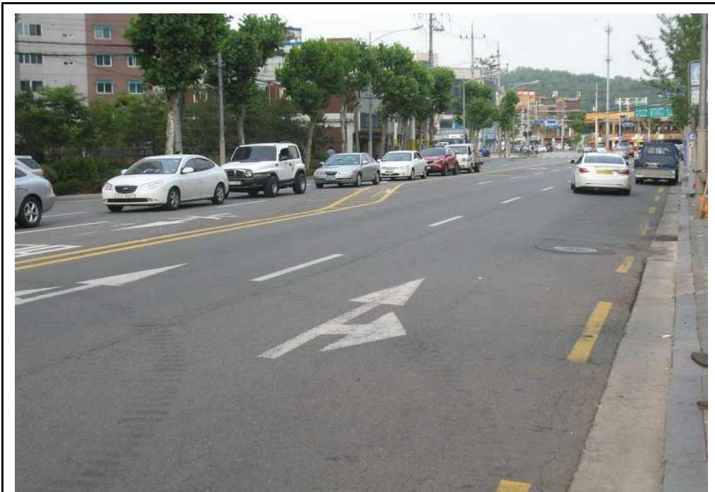
4륜Box구간 상부 전경
