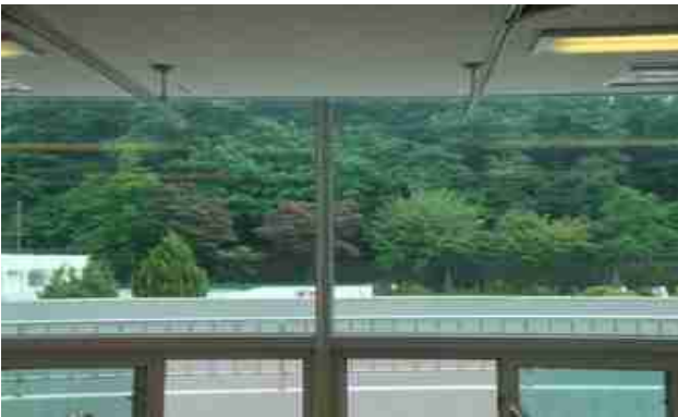
단열필름 설치 전
