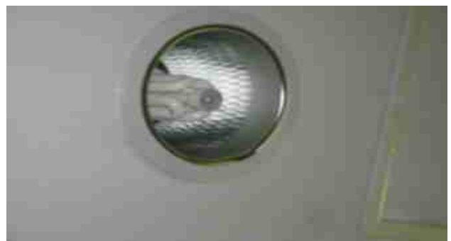
화장실 동체감지 센서 점멸등 설치 후
