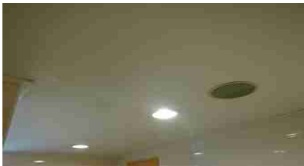
화장실 동체감지 센서 점멸등 설치 전
