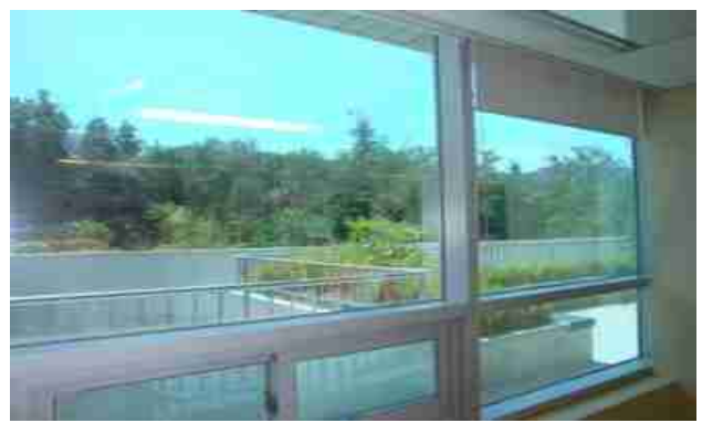
단열필름 설치 후
