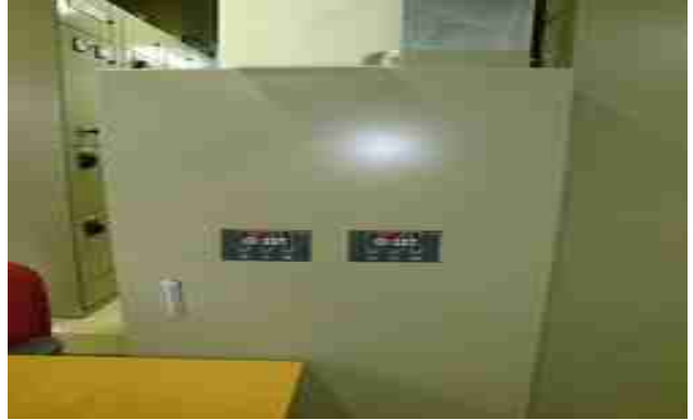
INVERTER 설치 후
