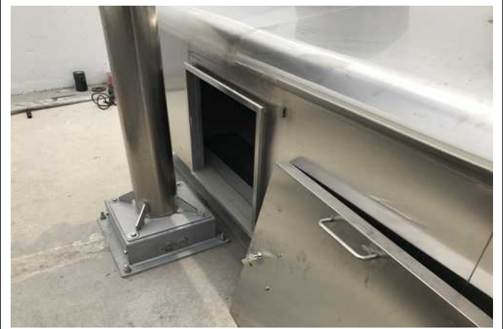
권양기 제어반 배기팬 설치 (조명등은 설치안하는걸로 강서구청 협의)
